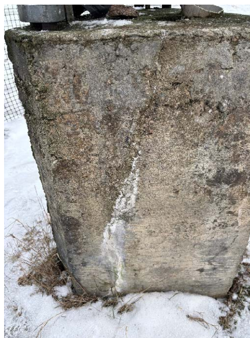
Bilde 13: På fundamentet F3 ble det registrert et riss med litt kalkutfelling på nedre del.
