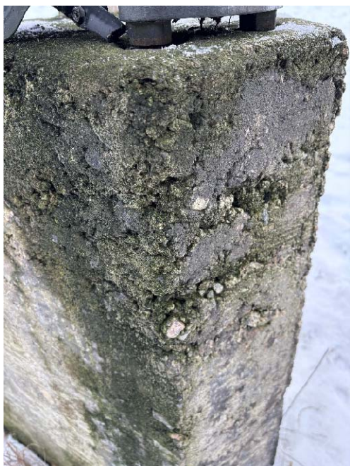
Bilde 10: På F2 og F3 var det stedvis noe dårlig utstøping som vises i form av grove tilslag/reir i overflatene (bilde fra F3).
