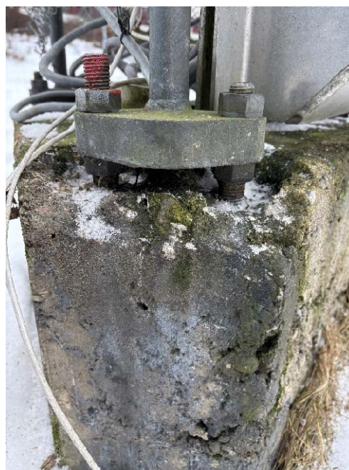
Bilde 11: På F2 ble det registrert at det er hugget vekk litt betong rundt forankringsstagene, trolig gjort for å kunne justere/stramme bolter ved montering.
