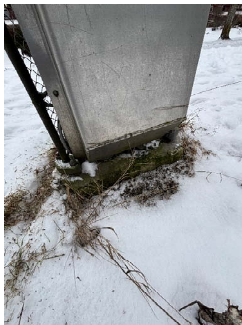
Bilde 5: Fundament for mast F1, som ligger helt ned mot terrenget.
