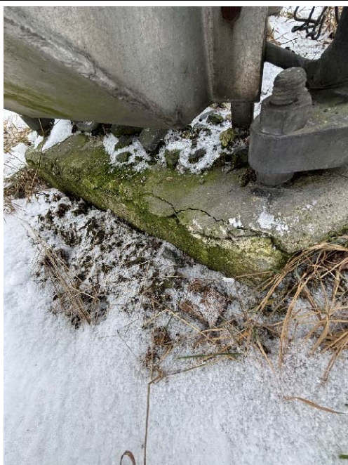
Bilde 12: Det ser ut til å være støpt/lagd en avretting på toppen av fundamentene, på F1 er det noen avskallinger på kanten.
