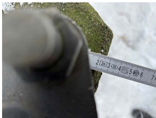
Bilde 9: Generelt liten kantavstand fra forankringsstagene og til betongkantene på fundamentene.
