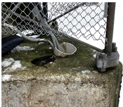
Bilde 8: Det ligger utsparing/ trekkør opp fra fundamentene i F2 og F3. Trekkørret/utsparing er åpent.
